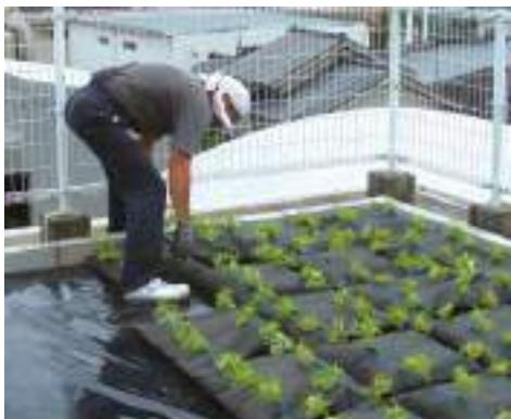
一般的な屋上緑化システムでは「構成する部品が多い」、「飛散防止のための強固な固定」、「運搬時の土壤飛散の懸念」など、防水改修に多大な労力を要します。一方、常緑キリンソウ袋方式<sup>®</sup>は「**袋を置くだけの構成**」、「**固定せずとも風速45m/sまで耐えられる**」、「**運搬時の土壤飛散ゼロ**」のため、防水改修も容易に行えます。
